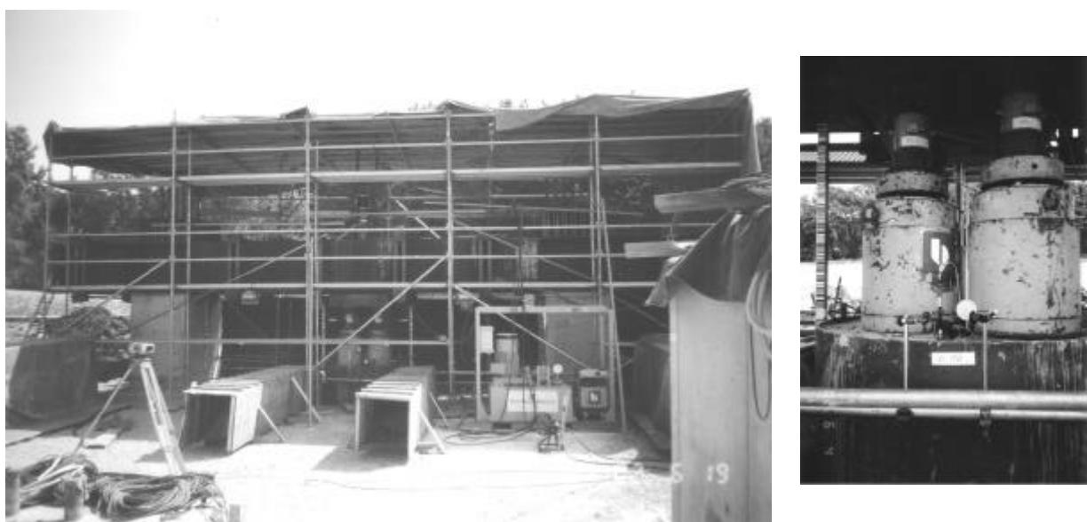
Abb. 5: Überblick über die aufgebaute Pfahlprobekonstruktion
