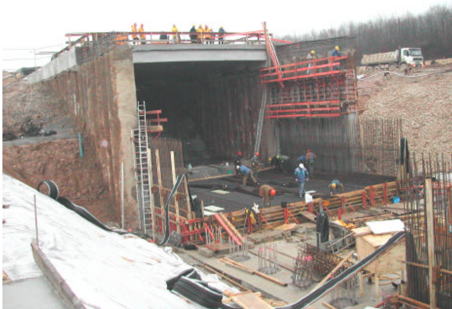
Bild 11: Hergestellte Bohrfahlwand mit Deckel im Bereich der späteren Druckluftschleuse
