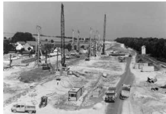
Abb. 5: Herstellung der Tunnelwände
