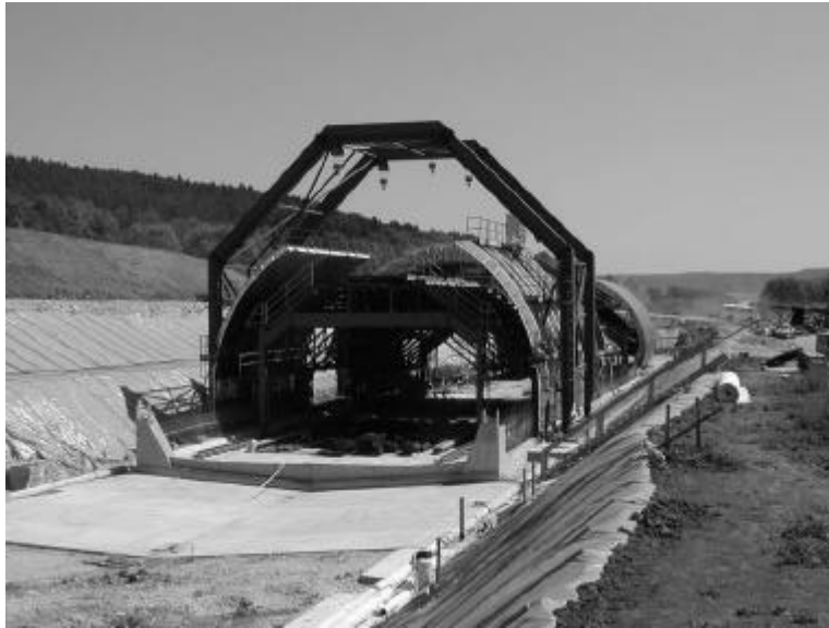
Abb. 2: Amtsentwurf: flach gegründeter Tunnel in offener Bauweise
