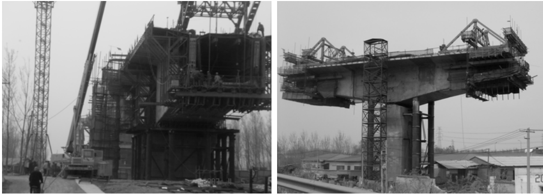
Bild 3 Durchlaufträgerbrücken in Ortbetonbauweise, hier Freivorbau
