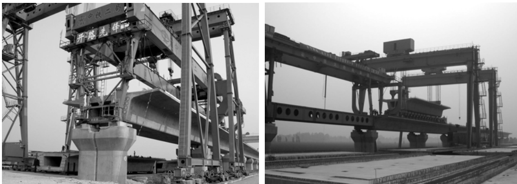
Bild 2 Einbau der Fertigteil-Hohlkastenträger
