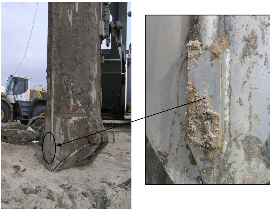
Abb. 7: Ausrüstung eines Verdrängungsrohres mit Messtechnik für Erfassung akustischer Signale
