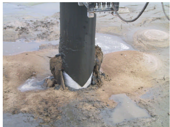
Abb. 1: Funktionsprinzip und Herstellung mit dem Verdrängungsverfahren
