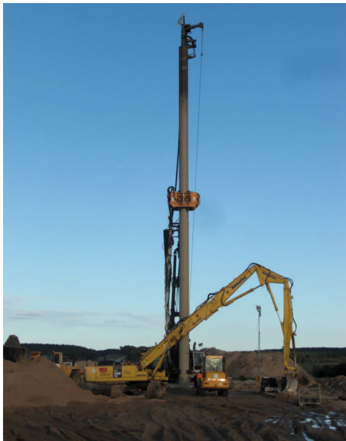
Abb. 6: Trägergerät LRB 255 mit 30 m langem Verdrängungsrohr auf einer Baustelle in Polen
