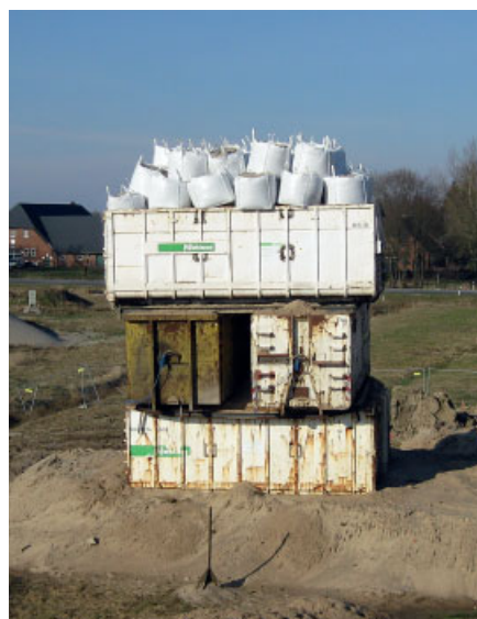
Bild 4. Vollständige Belastung der Säulengruppe Fig. 4. Full loading of columns
