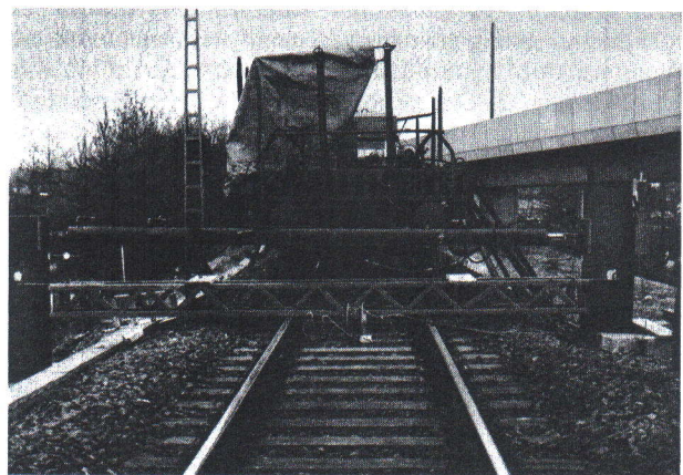
Bild 3. Horizontale Probebelastung an kurzen Pfählen
