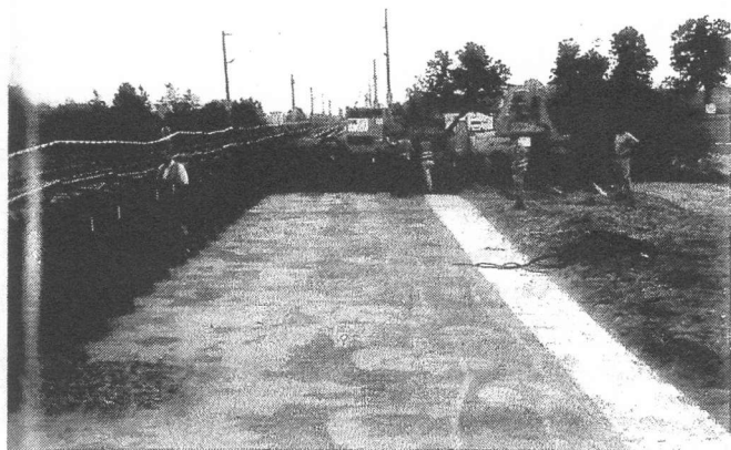
Bild 3: Großschurf im Sommer 2001; eingepresste Spundwände und freigelegtes Geogitter
