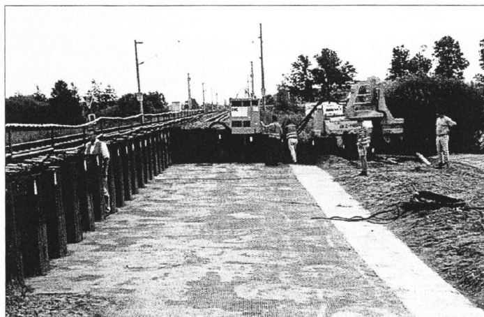
Bild 3: Großschurf im Sommer 2001; eingepresste Spundwände und freigelegtes Geogitter
