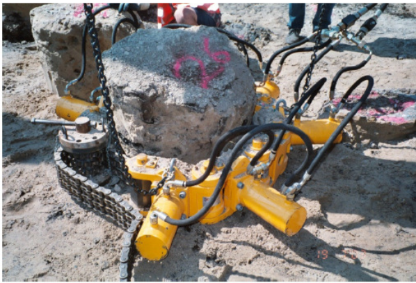
Abb. 28: Nicht optimal ausgebildete teilvermörtelte Säulen
