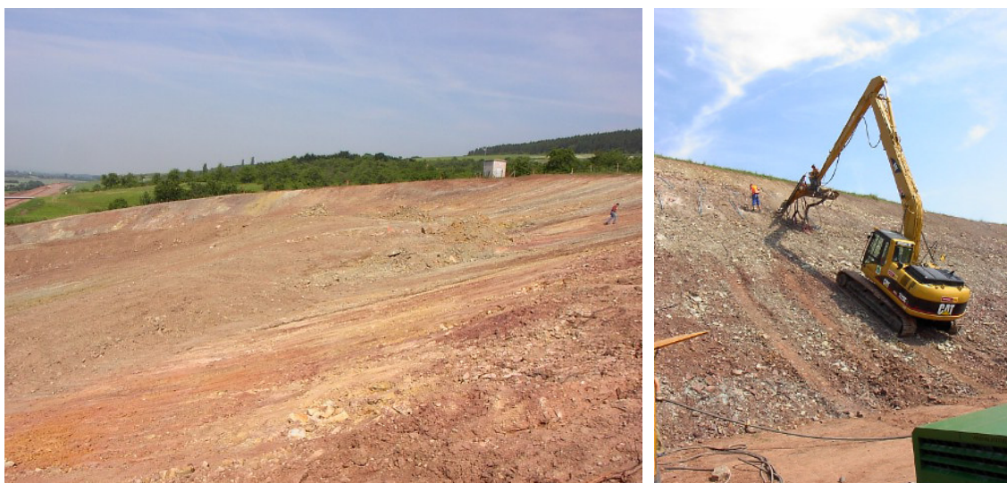
Abb. 18: Sanierung a) abgeflachte Böschung, b) Vernagelung
