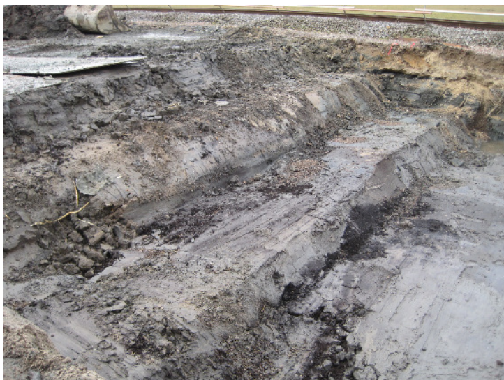
Abb. 37: Aushub für den keilförmigen Betonkeil an den Übergangsbereichen von FWTG auf die freie Strecke (links Tragplatte)
