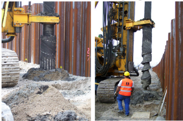
Abb. 33: Herstellung der Vollverdrängungsbohrpfähle
