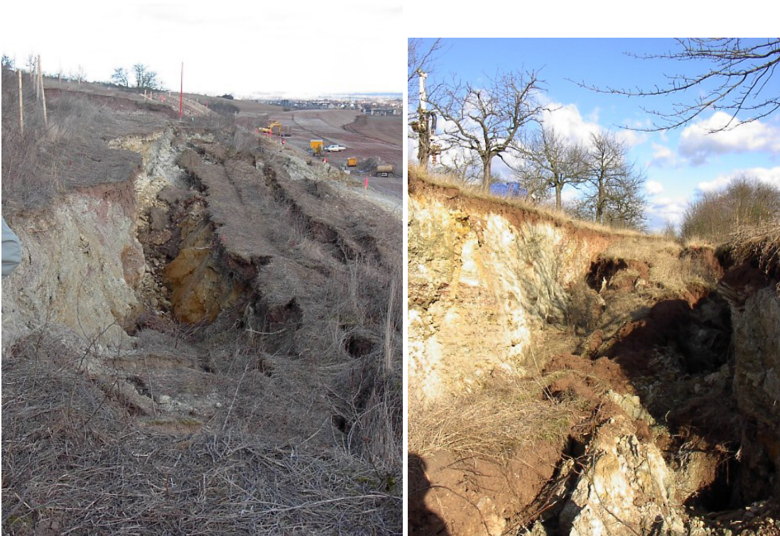
Abb. 13 (links): Bereich der ehemaligen Böschungsschulter
