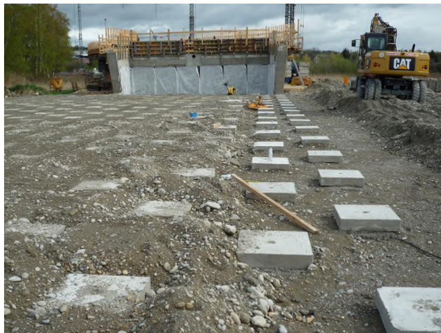
Kopfplatten aus Stahlbeton auf Säulen
