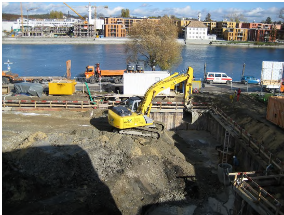
Ansicht Gebäude und Aushub Baugrube mit Spundwand
