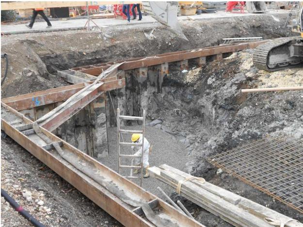
Abb. 1: Aushubabschnitt Eckbereich Spundwand
