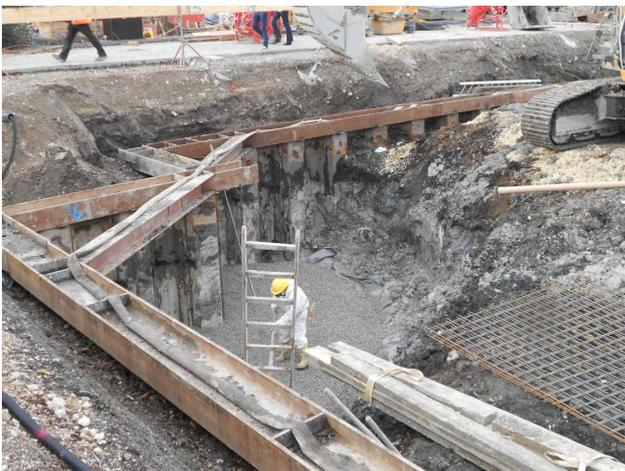
Abb. 1: Aushubabschnitt Eckbereich Spundwand
