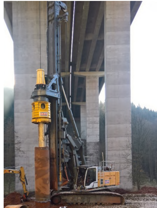
Abb. 2: Herstellung der Probelpfähle
