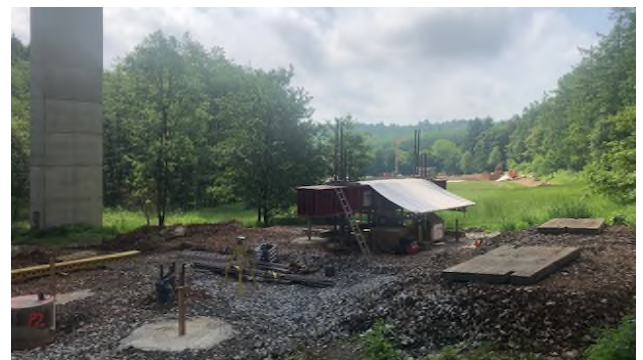
Abb. 3: Durchführung der Probelastungen
