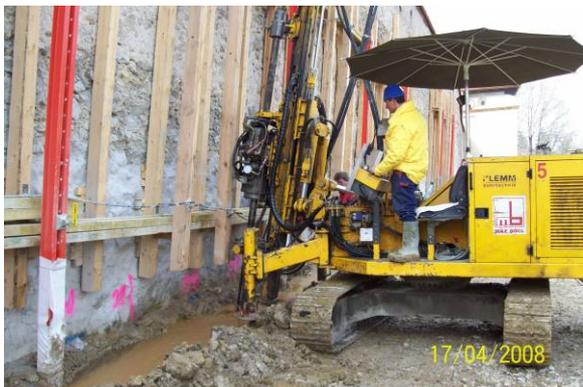
Bei der Ausführung der Unterfangung war entscheidend, dass der Düsenstrahlgründungskörper mindestens 50 cm in die anstehende Kiesschicht einbindet und dass an der unebenen und aus unverfugtem Bruchstein bestehenden Unterkante der Mauer ein kraftschlüssiger Verbund entsteht. Letzteres wurde nach Herstellung und Aushärtung stichprobenartig an mehreren Stellen des sanierten Mauerabschnitts mittels Baggerschürfen nachgewiesen.
