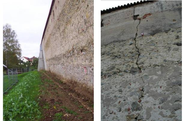
Aufgrund der eingetretenen Situation mit fortschreitender Deformation und Schiefstellung der Mauer war eine sofortige Sperrung des sonst rundum begehbaren Wehanges im betreffenden Stadtmauerabschnitt sowie eine kurzfristige Analyse der Schadensursachen und Durchführung einer zielgerichteten Sicherung und Ertüchtigung erforderlich.
