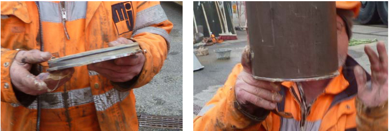
Abbildung 8: Stopper für Schüttrohr (links) und im eingebauten Zustand (rechts)
