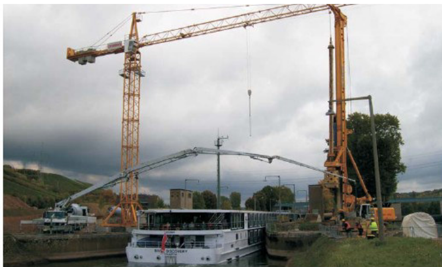
Neubau der Mainbrücke Goßmannsdorf - Bohrpfahlgründung (D = 1,5 m; L = ca. 50 m)
